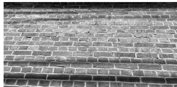
イギリス積みレンガの壁
