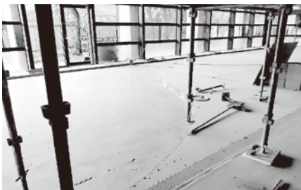
一般開架閲覧室の床改修
