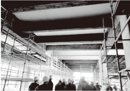
高天井の一般開架スペース
