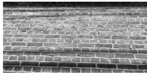
イギリス積みレンガの壁
